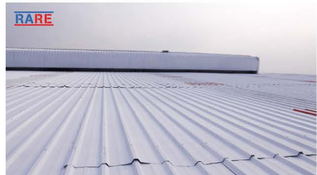
Bề mặt mái tôn được phủ bởi sơn làm mát bức xạ RARE
